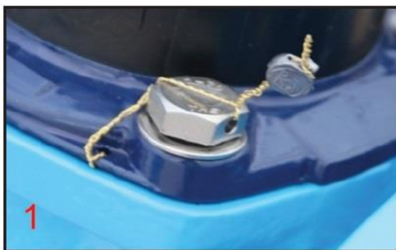
Слика 2. Приказ места жигосања везе једног од вијака главног водомера и кућишта
