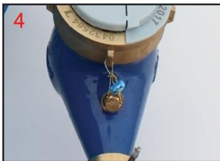
Слика 5. Приказ места жигосања везе прстена од месинга споредног водомера и вијка за подешавање
