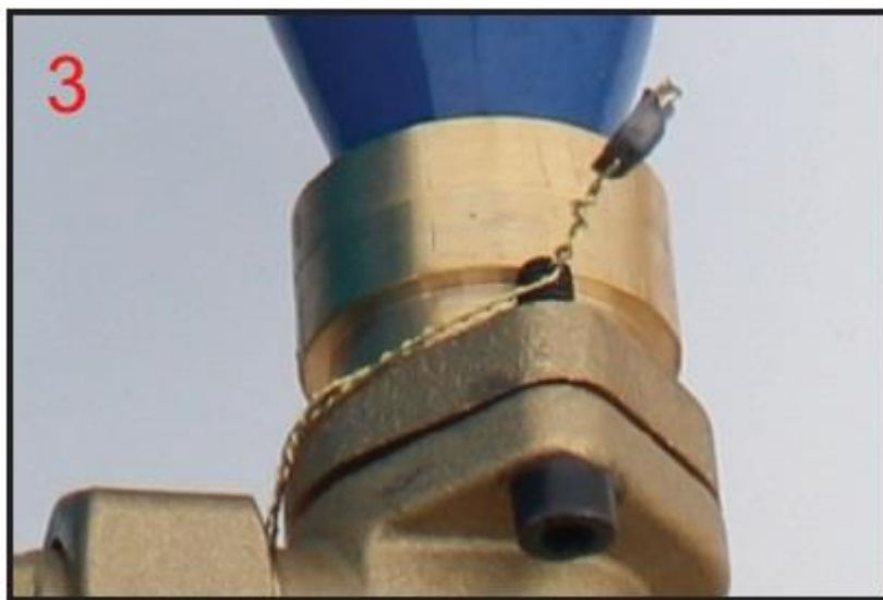
Слика 4. Приказ места жигосања цеви која повезује главни и споредни водомер
