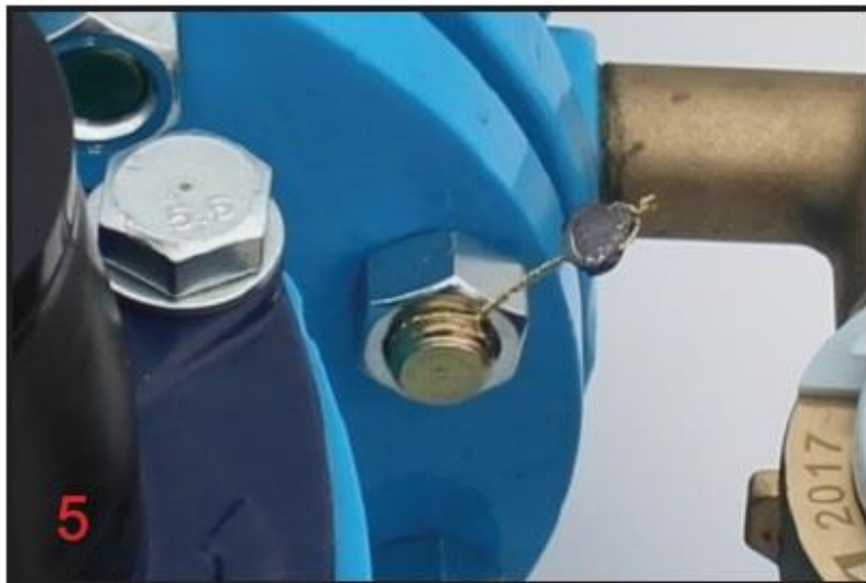
Слика 6. Приказ места жигосања везе једног од вијака, који повезује тело главног водомера, и преклопног вентила
